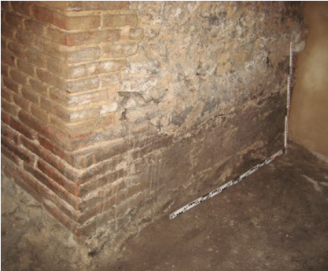
Figura 5. Vista de la parte inferior del muro compartido con la cisterna-1 de la canalización. Detalle ladrillos originales y marcas de encofrado.
