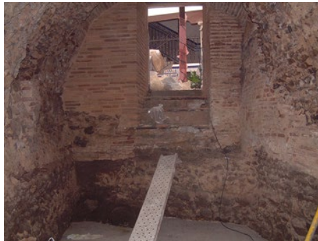
Figura 13. Vista de la cara exterior de la cisterna-2 desde el sótano colindante.
