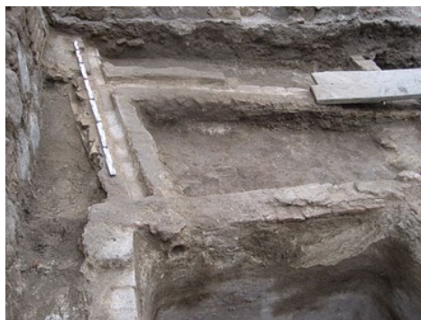
Figura 16. Canal y tubería acometida a noque.
