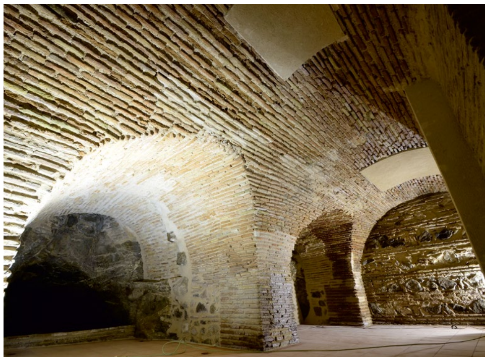
Foto 6. Aspecto de las estructuras abovedadas al finalizar la rehabilitación.
