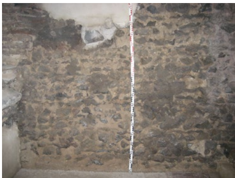
Figura 8. Vista del muro de cierre lateral de la cisterna-1.
