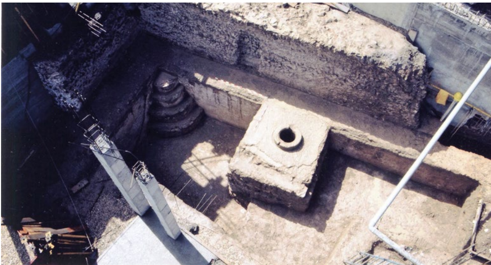
Figura 2: Foto del ángulo suroeste de la natatio durante las obras en que se descubrió.
