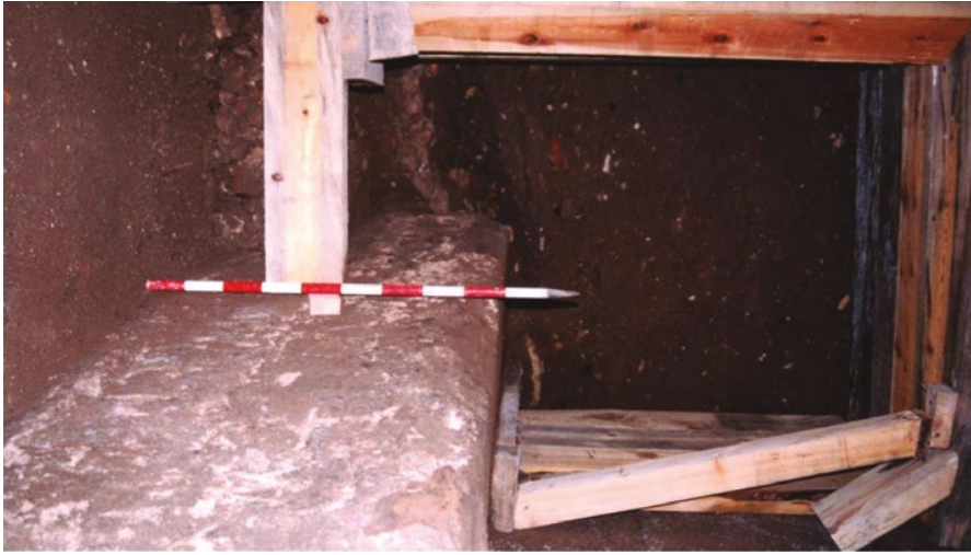
Fig. 5. Detalle del rebosadero, en la parte superior del muro NO.
