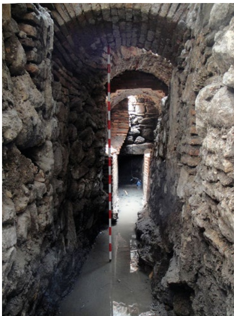
Figura 5. Interior de la cloaca principal de la Bajada del Barco en el que se identifica tanto el canal original como las reformas posteriores de épocas medieval y moderna (Fotografía: A. Ruiz Taboada).
