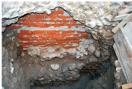
Fig. n° 4.- Subsuelo de plaza entre Complejos A y D. Galería o conducto central Complejo D.
