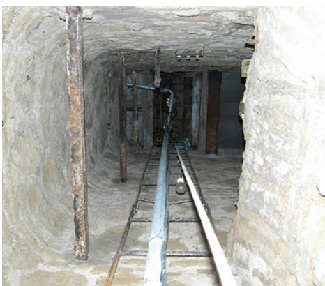
Fig. 23. Detalle del interior del pozo de la noria del Cigarral de Menores con el arco de apoyo para la maquinaria.
