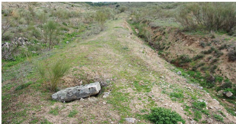
Fig. 11. Vista de la cubierta de la galería de la captación de Pozuela 1.
