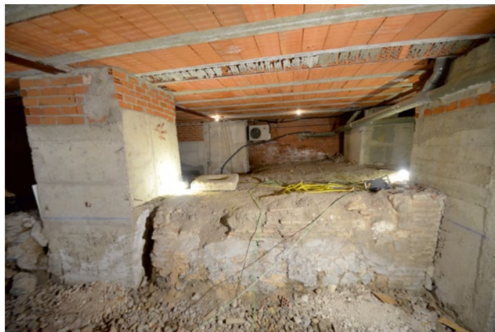
Foto 2. Estado inicial del sótano del nº 3 de la Trinidad. Aspecto exterior de las bóvedas y suelo del patio original de la casa medieval.
