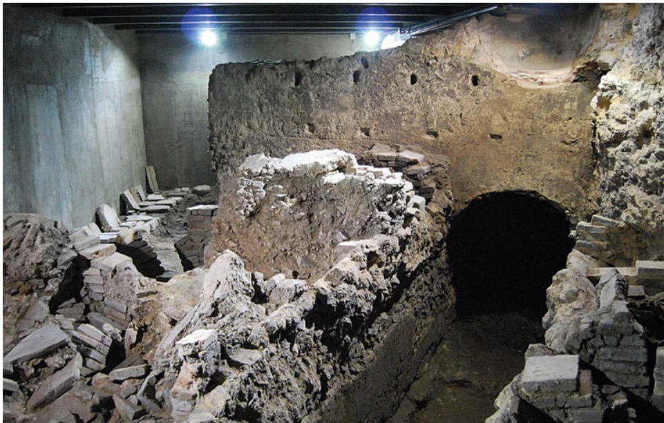
Fig. nº 12.- Complejo C. Galería o conducto abovedado. Vista desde el noroeste.
