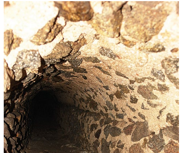
Fig. 7. Canalización. Detalle bóveda.
