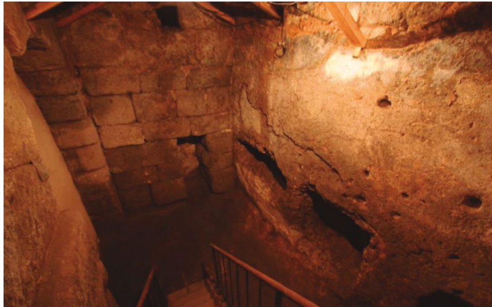
Fig. 4. Interior de la "cisterna". Muros NE (derecha) con revestimiento de "opus signinum" (I fase) y NO (izquierda) con adosamiento de "opus quadratum" (II fase).
