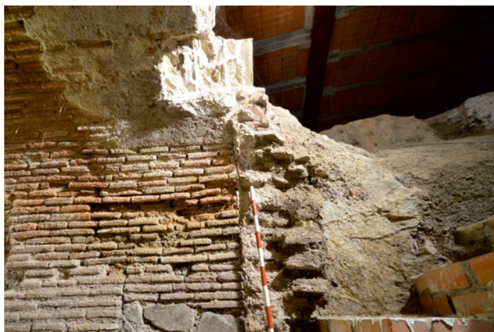
Foto 3. Muro de cierre norte del sótano original que corta la roca natural.
