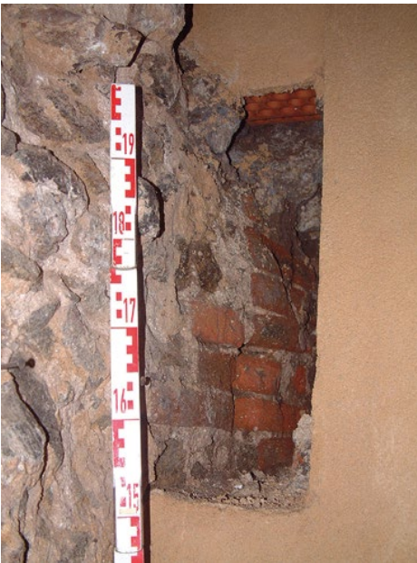
Figura 6. Detalle restos ladrillos de un arco romano en el cierre norte de la canalización.
