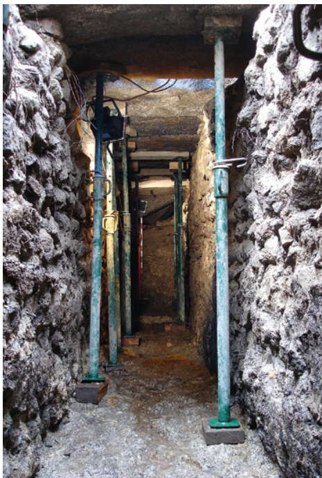
Figura 3. Tramo adintelado de la cloaca del Cristo de la Luz (Fotografía: A. Ruiz Taboada).
