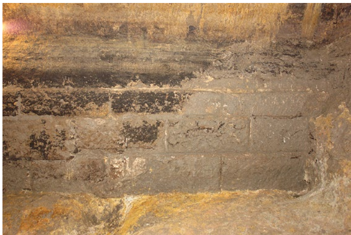
Fig. 8. Cisterna. Perfil Oeste.
