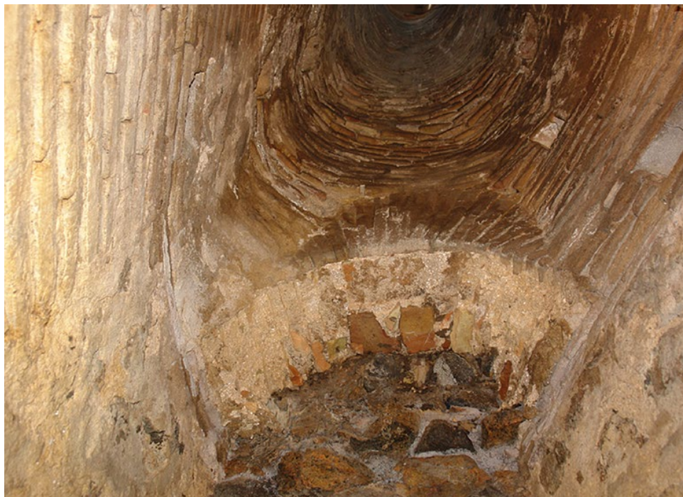
Fig. 11. Aljibe Sótano. Conexión con cisterna.
