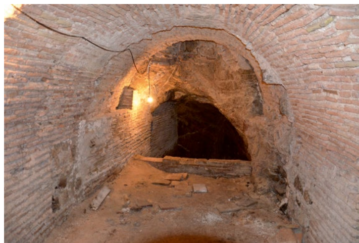
Foto 4. Estado inicial de la bóveda de acceso al pozo-manantial
