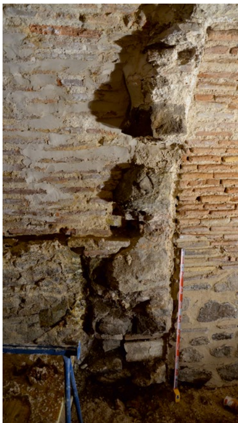
Foto 7. Muro de cierre norte del sótano original que corta la roca base.
