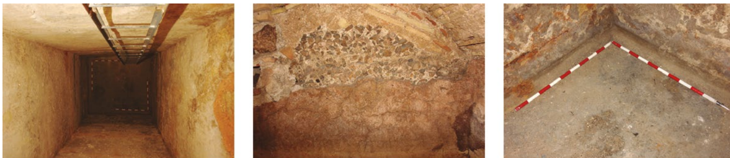
Fig. 4. Cisterna de Juan Labrador.
