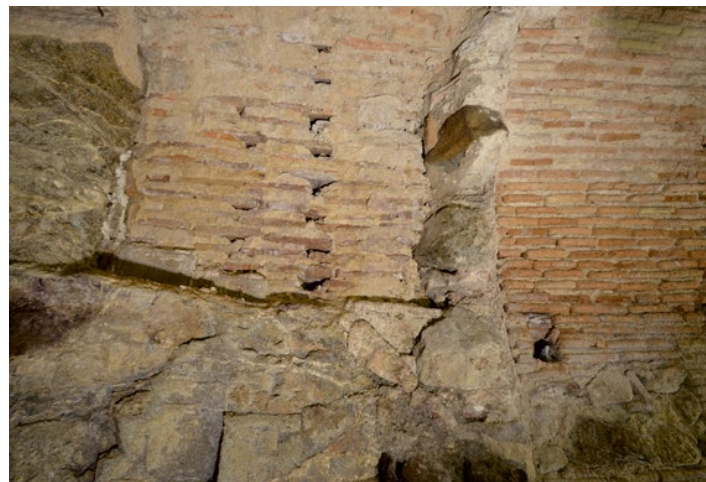
Foto 12. Construcción del acceso lateral al pozo manantial derribando el muro norte de la fase inicial y cortando la roca base.
