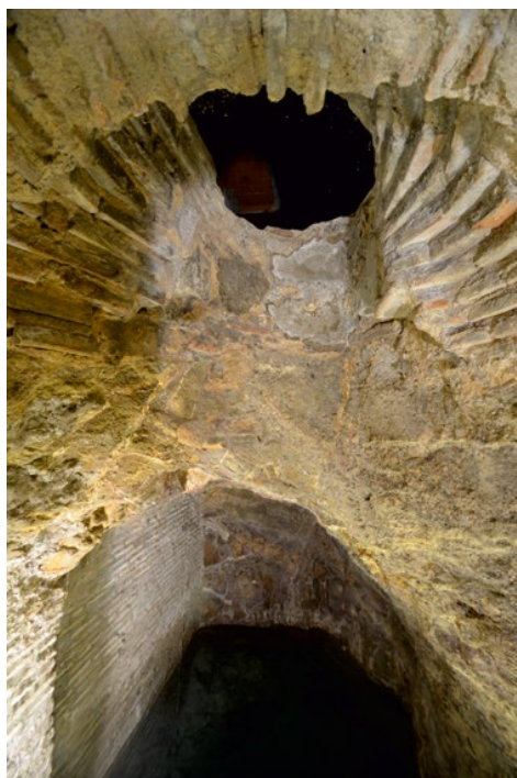
Foto 5. Imagen actual del Pozo-manantial excavado en la roca base. A la izquierda el muro actual de la reforma de 1954.
