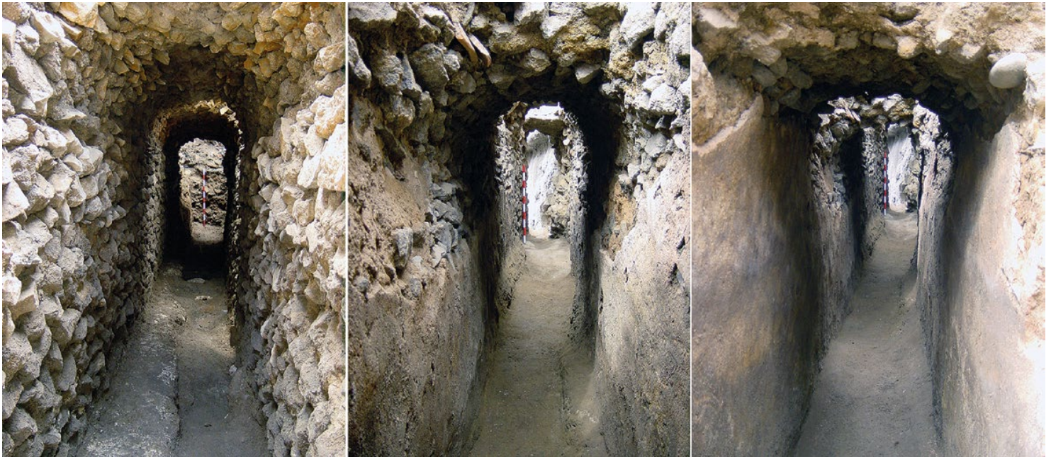
Figura 7. Interior de distintos tramos de la cloaca del Juego de Pelota y detalle de los restos de revoco hidráulico y el specus (Foto: A. Ruiz Taboada).
