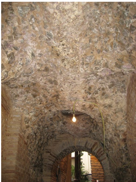
Figura 4. Canalización central, detalle bóveda arista, registro y junta de dilatación.
