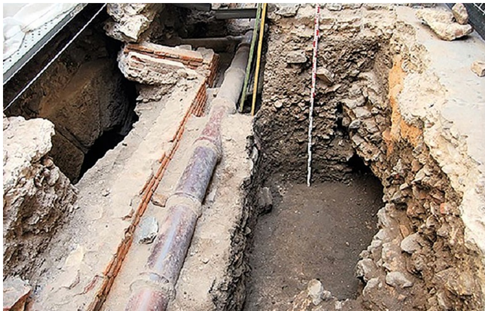
Fig. nº 2. Subsuelo de plaza entre complejos A y D. Arco sur (izqda.) y galería o conducto central Complejo D (dcha.).
