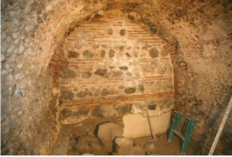
Figura 9. Vista de la cisterna-1. Bóveda y cierre norte con muro islámico.
