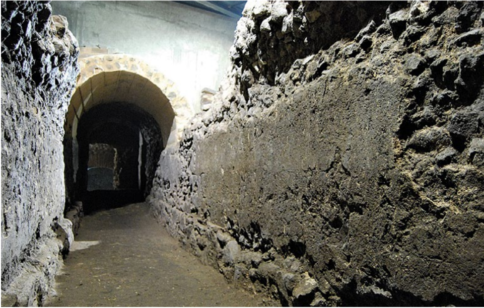
Fig. nº 11.- Complejo C. Galería o conducto abovedado. Vista desde el sureste.
