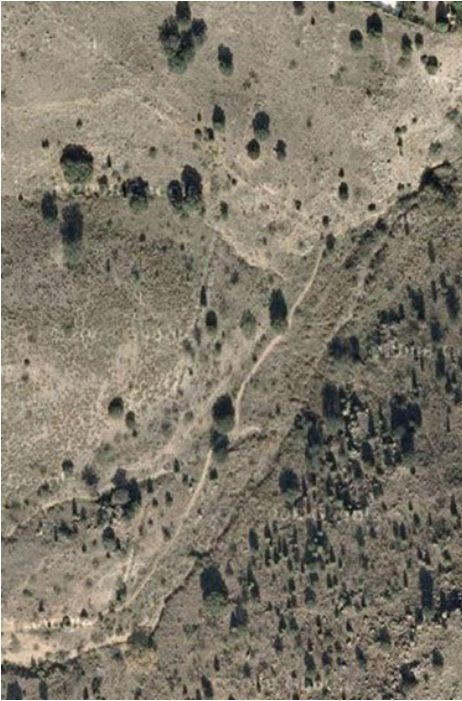
Fig. 7. Vista aérea del trazado lineal que presenta la conducción atribuida a época romana y que responde a las obras realizadas en el siglo XIX en la antigua Dehesa de Pozuela. Fuente: Google Maps.
