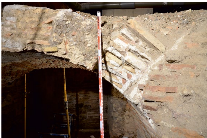
Foto 11. Arquería de la fase inicial, reutilizada en la fase de construcción de las actuales bóvedas. Sótano de la Trinidad nº 5.
