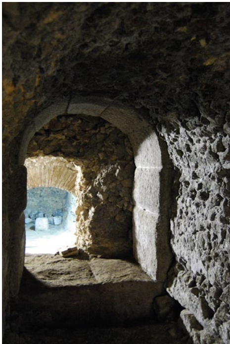
Fig. nº 9.- Complejo C. Arco norte. Vista desde el sureste.
