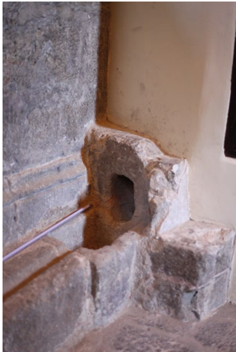
Fig. 4b: Planimetría y detalles de la pileta y del canal que desagua al exterior.
