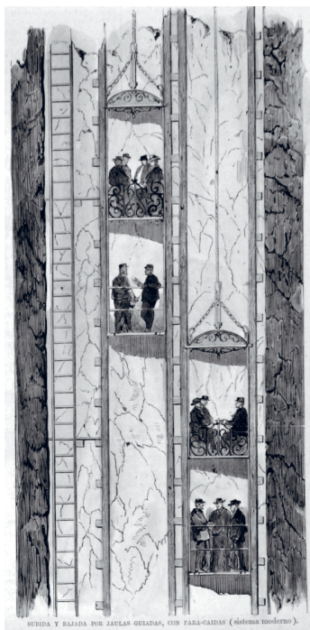
Figura 2. Subida y bajada por jaulas guiadas, con paracaídas, en los pozos de la mina de Almadén. La Ilustración Española y Americana [1874, p. 301]
