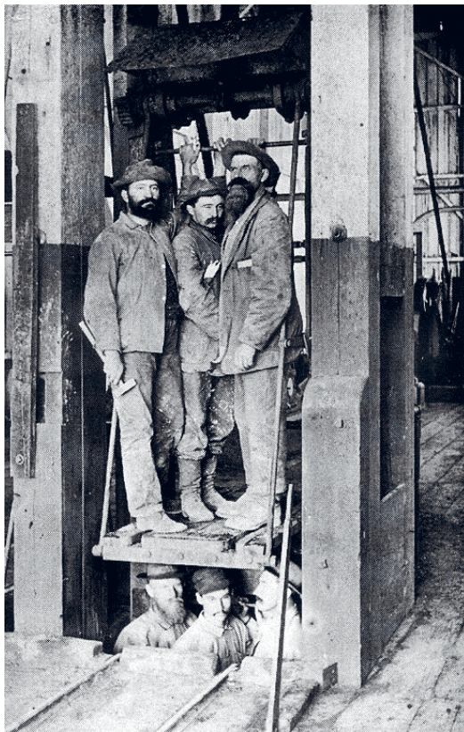
Figura 6. Mineros de New Almaden descendiendo en dos jaulas superpuestas por el pozo ‘Randol’ [L. E. Bullmore collection]
