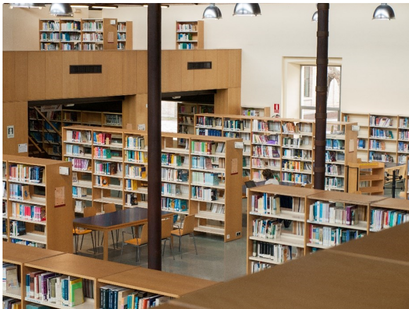
Figura 1 Detalle de la sala de lectura de la biblioteca antes de la intervención Fuente: Francisco Javier Gómez Lobera
